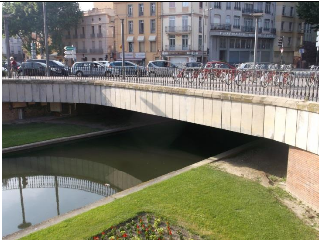
Pont de Larminat
